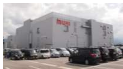
池田模範堂 第2工場 (H28.11.25竣工)
